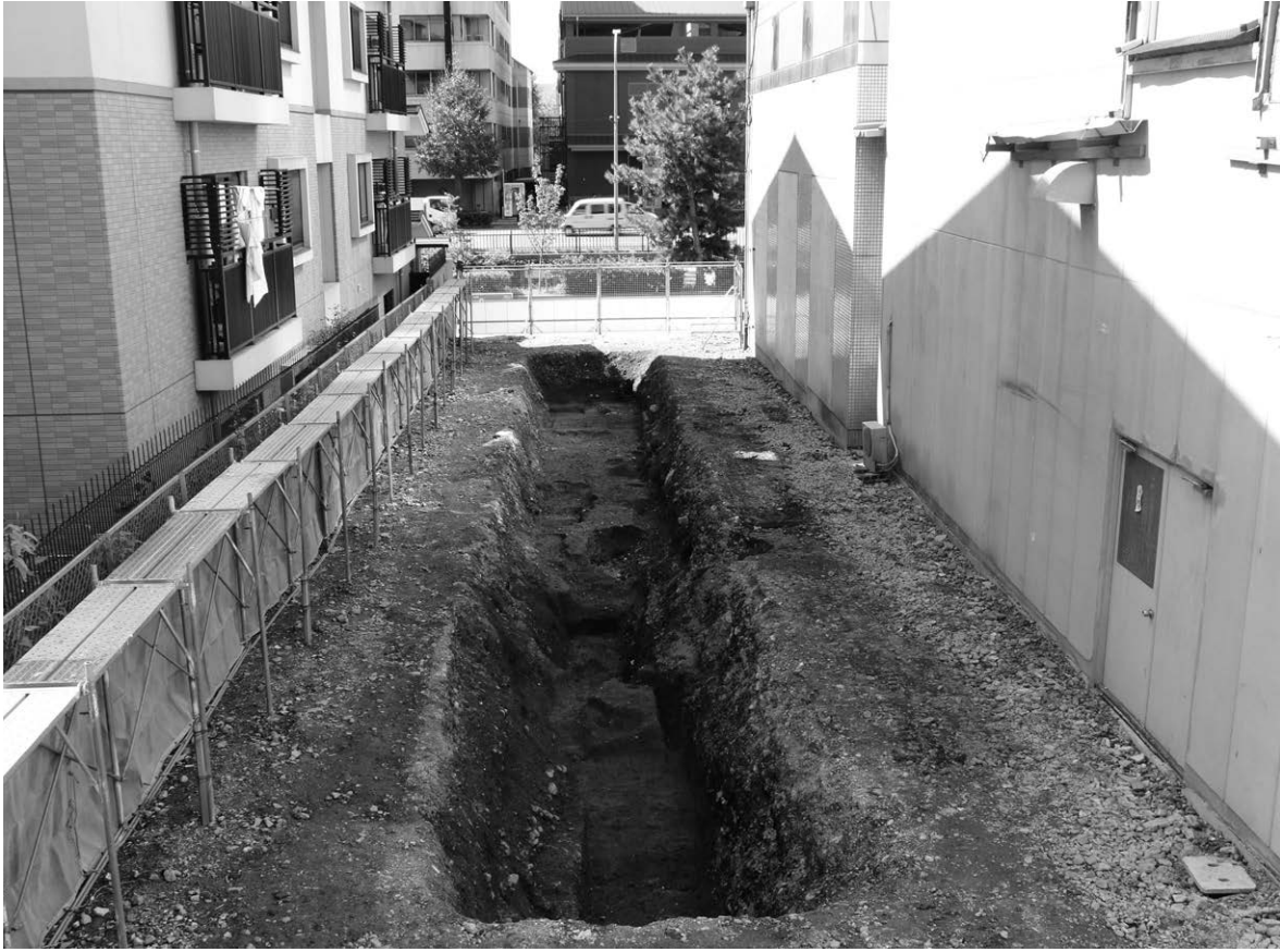
第2面 調査区西半全景（東から）
